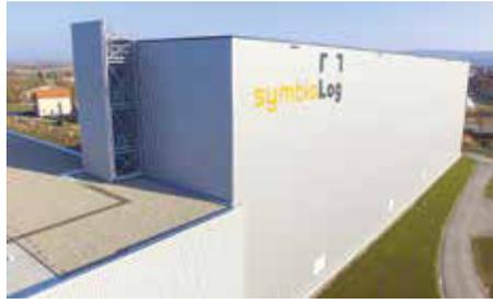
Das automatische Palettenlager ist als Hochregal in Silobauweise errichtet, die Regalkonstruktion trägt also die äußere Gebäudehülle.
