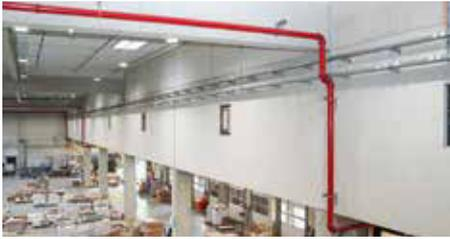
Die Gebäudekonstruktion besteht aus Stahlbetonstützen und -fertigteilen. Insgesamt kam häufig Sichtbeton zum Einsatz.
