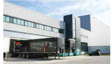
Bereich des Warenein- und Warenausgangs. Die zweischalig gedämmte, graue Kassettenfassade vermittelt ein einheitliches Bild.
